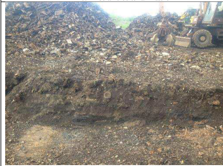
PFI Est : épaisseur de remblais à traiter par criblage/aimantage. Au sol, dalle en briques perrusson
