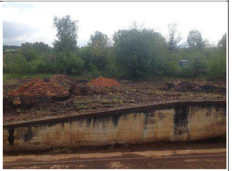
PFI Ouest, avant confinement, vue sur le terrain naturel issu des fouilles
