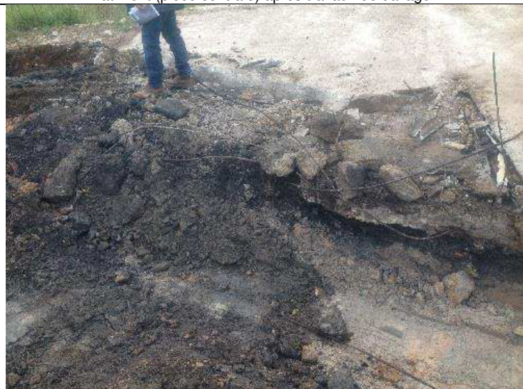
Travaux sur ancienne zone cisaille
