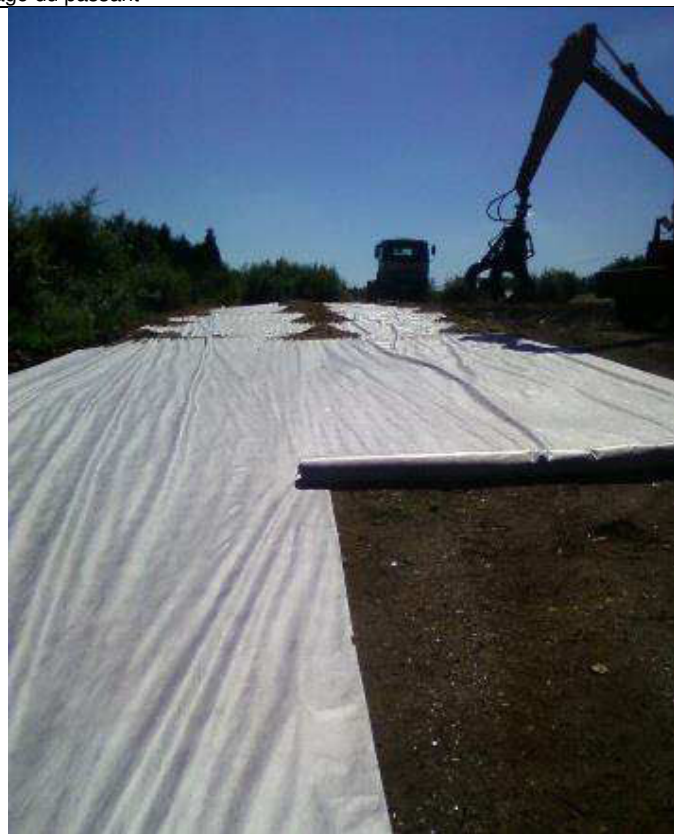
PFH Ouest : mise en place du bidim
