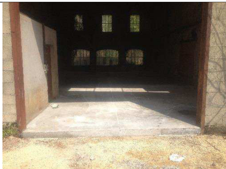
Bâtiment (pièce centrale) après travaux de dallage
