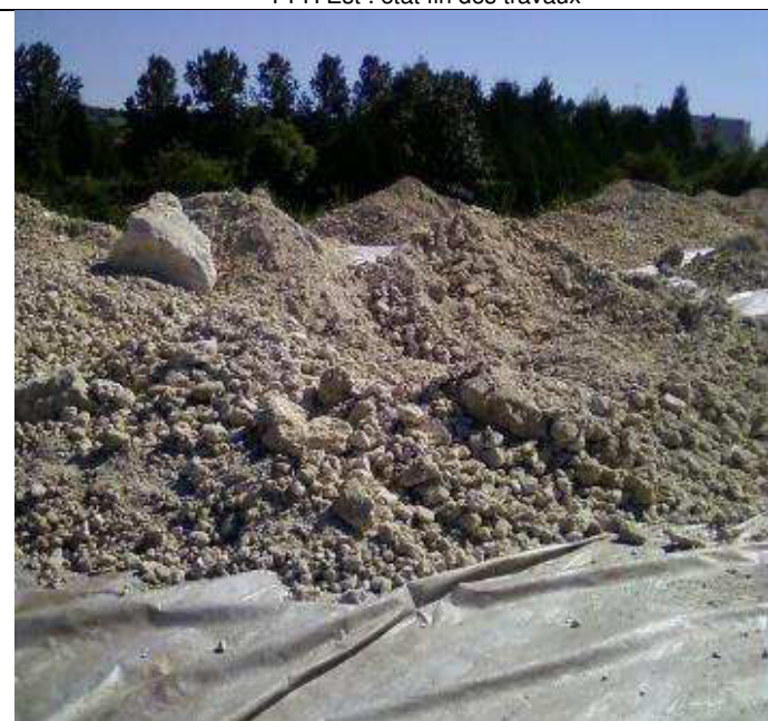
PFH Ouest : mise en place du bidim puis des matériaux de confinement
