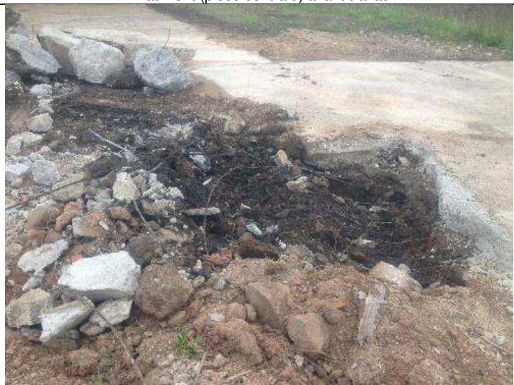
Travaux sur ancienne zone cisaille
