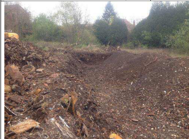
PFI Est : de gauche à droite, refus de cribles, épaisseur de remblais à traiter, stock de passants
