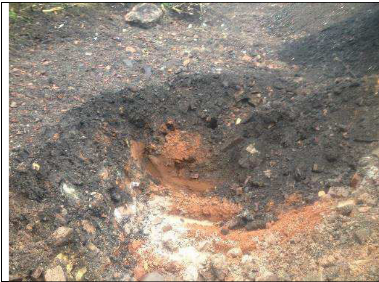
PFI Est : mise à nu du terrain naturel
