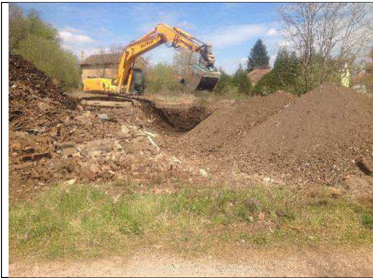
PFI Est : opération de criblage. De gauche à droite, refus de cribles, pelle cribleuse sur couche de remblais a traiter, stock de passants
