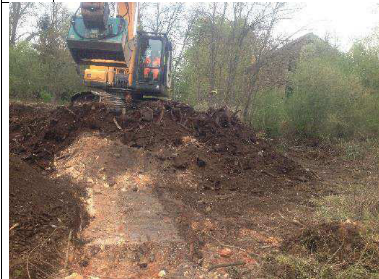
PFI Est : mise à nu de la dalle en briques Perrusson
