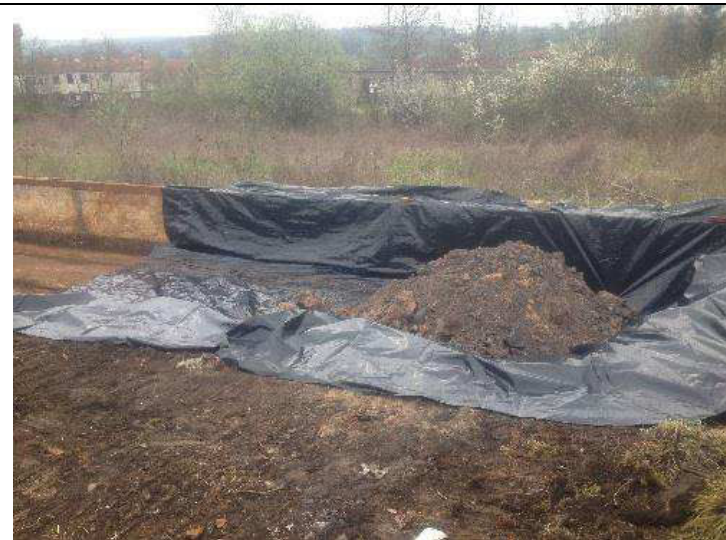
Mise en stock provisoire des terres polluées aux hydrocarbures de l'ancienne zone cisaille
