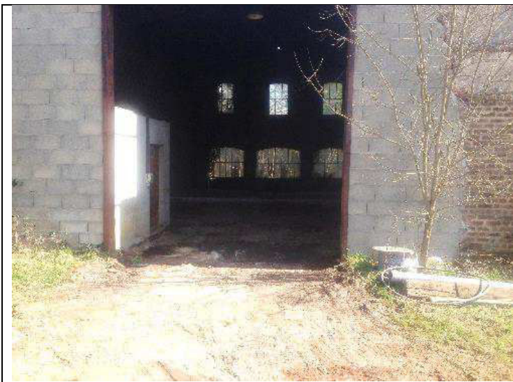
Bâtiment (pièce centrale) avant travaux
