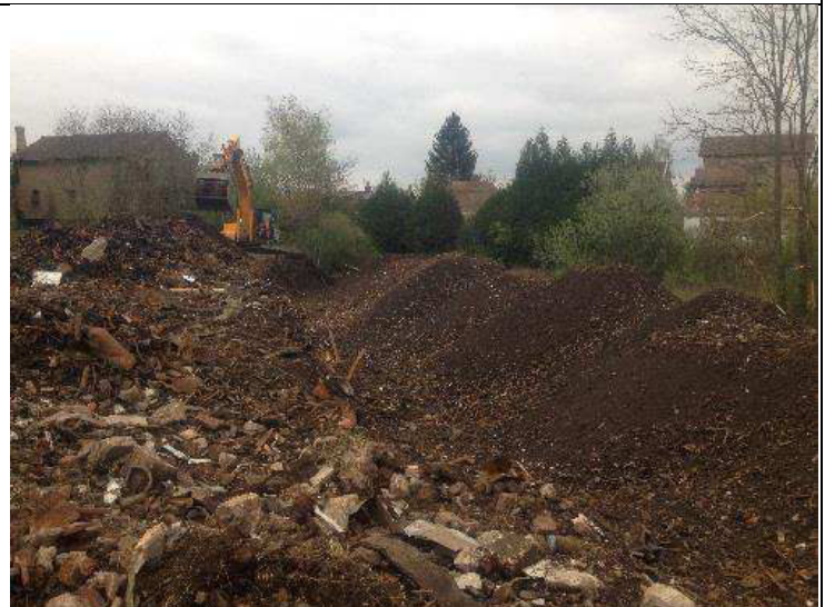
PFI Est : opération de criblage. De gauche à droite, refus de cribles, pelle cribleuse, stock de passants
