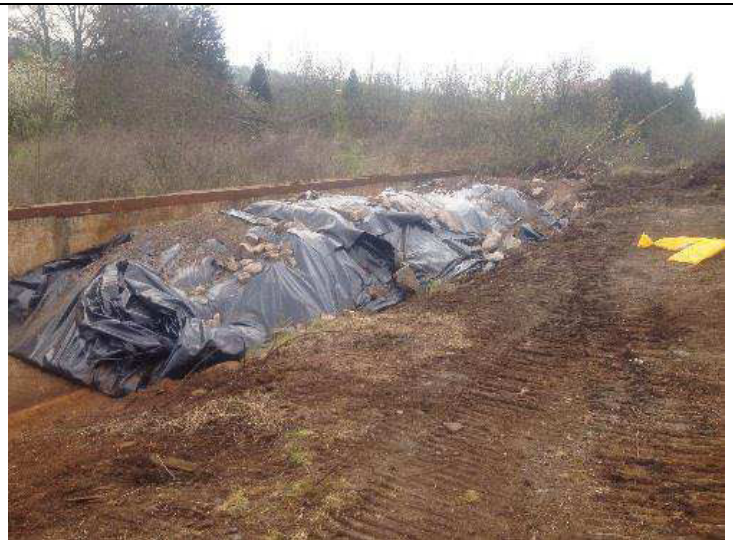
Mise en stock provisoire des terres polluées aux hydrocarbures de l'ancienne zone cisaille
